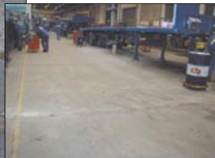
Fahrzeugwerke Faymonville AG, Billingen/Belgium: Repairing expansion joints
